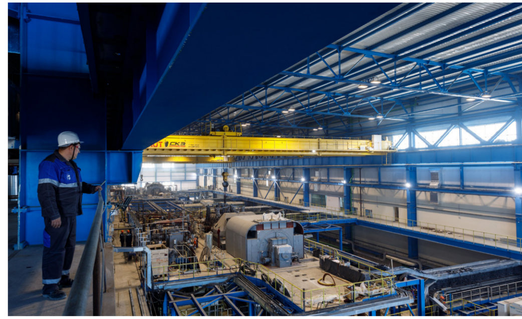
Энергетическое сердце электростанции — турбинное отделение котлотурбинного цеха. Монтаж основного оборудования здесь уже завершён
