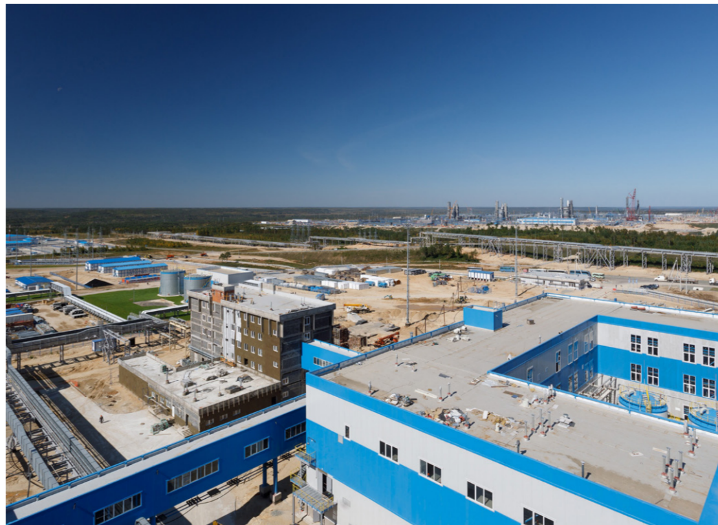
Со здания главного корпуса виден весь масштаб будущей территории Свободненской ТЭС и панорама стройплощадки Амурского ГПЗ
