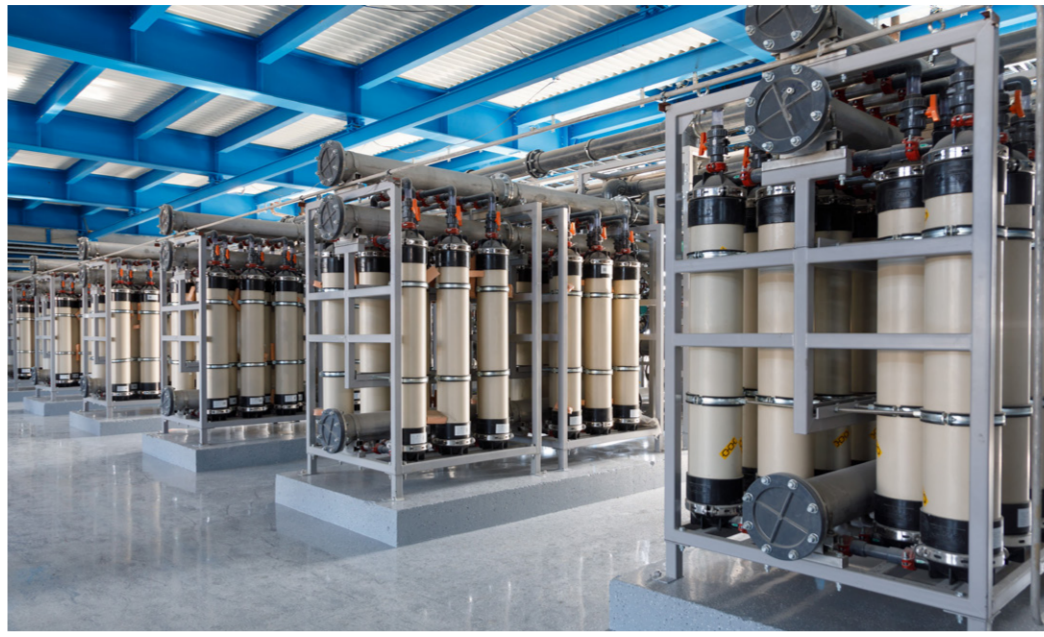
Зал водоподготовки химического цеха — одно из производственных помещений Свободненской ТЭС, в которых мы побывали с экскурсией
